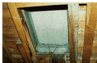
Tabatière occultée pour rendre un comble obscur
