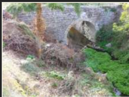
Pont vieux sur le Cizières au Treuil ©J.BEC
