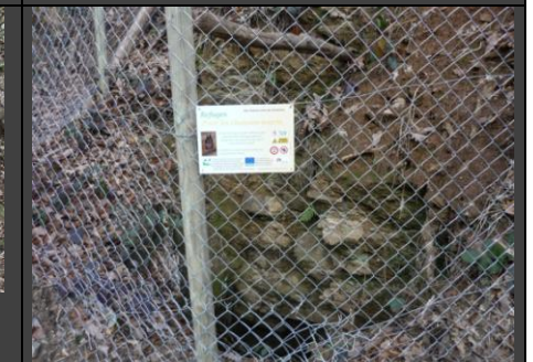
Panneautage sur les ouvrages © J. Bec
