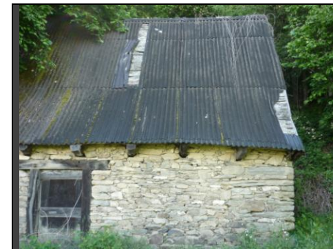
Grangette de Lagarrige avant travaux © J. Bec
