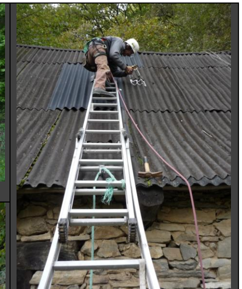
Grangette de Lagarrige en travaux © J. Bec
