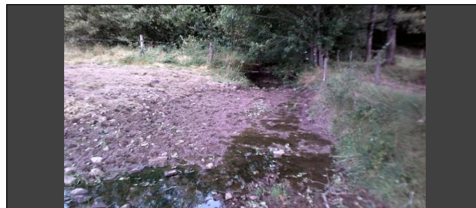
Passage en souterrain de la Ressègues par une taupe d'ENEDIS, le ruisseau n'est pas impacté
