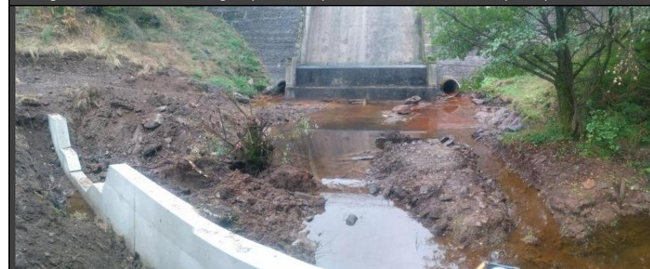
Création d'un batardeau et d'un bassin de rétention à l'aval du barrage de la Fontbelle
