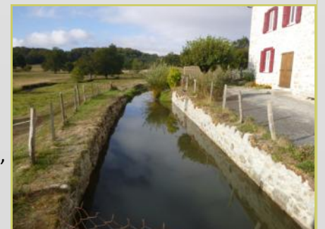
après travaux la retenue
