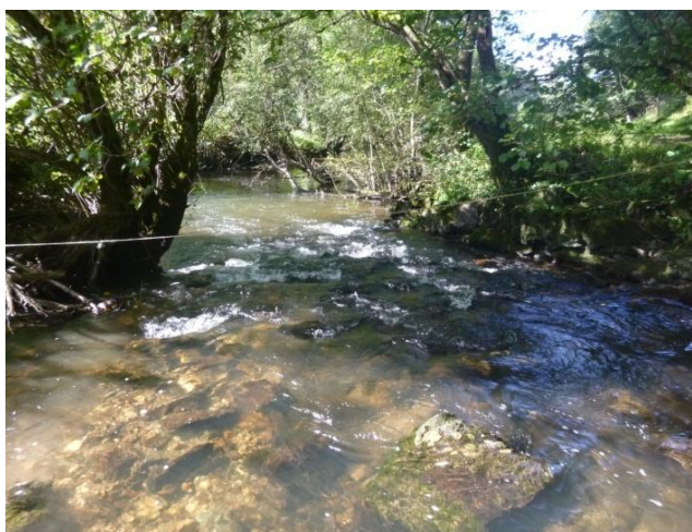
Ouvrage OA15_ROA : radier à l'amont immédiat de Roannes-Saintes-Mary
