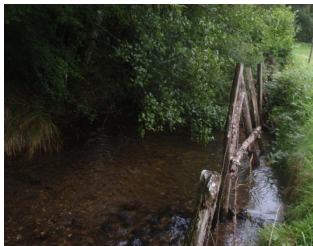
Piquets de clôtures déchaussés et suspendus au dessus du lit mineur (Roannes amont)
