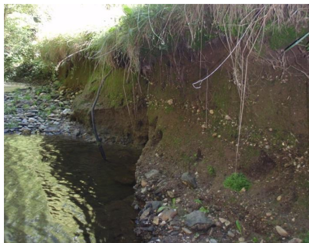
Erosion d'origine hydraulique dans le Roannes avec des matériaux pas toujours cohésifs en pied de berge
