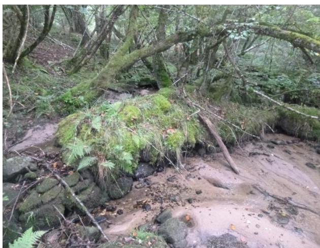
Ouvrage OA2_MOU : digue longitudinale sur l'amont du Moulès à proximité du lieu-dit « Moulès »
