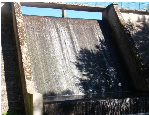
Ouvrage OA1_ESC (ROE44277) : barrage AEP de la Fontbelle sur l'Escalmels (Saint-Saury)
