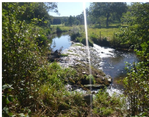
Ouvrage OA17_RES (ROE74456) : déversoir du moulin des Rhodes à l'aval de la Ressègue
