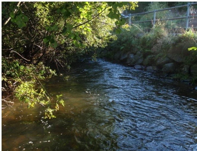
Enrochements en rive droite dans le Roannes (ROA41) à Roannes-Sainte-Mary
