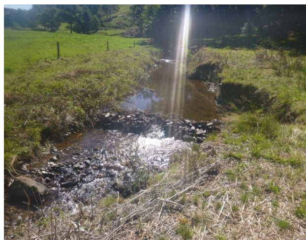
Ouvrage OA6_ESC : enrochements dans l'Escalmels au lieu-dit « Escalmels »
