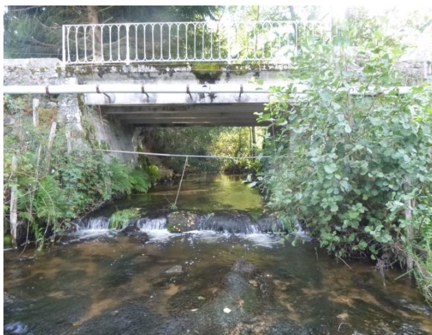
Ouvrage OA11_PON : radier de pont avec chute sur le Pontal à l'aval de la route D32 à Glénat
