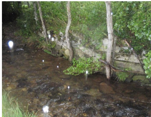
Mur béton/palplanches dans le Roannes (ROA6) à proximité de Prune
