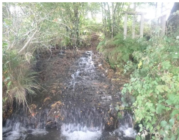
Ouvrage OA3_MOU : déversoir à l'amont du moulin de la Place sur le Moulès (vers Ségalassière)
