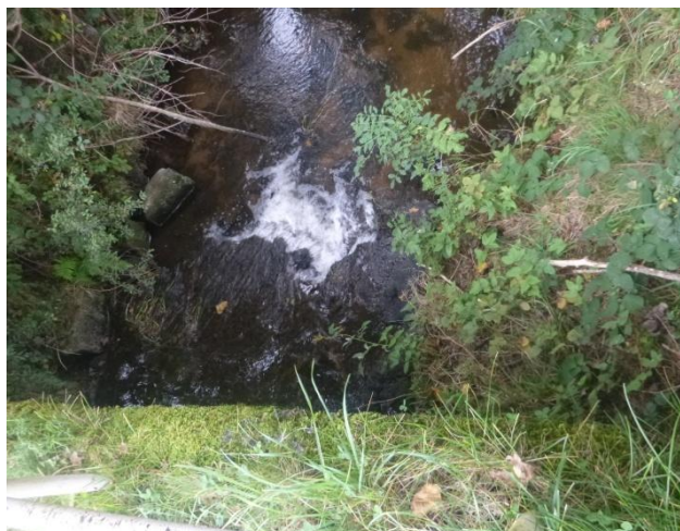
Ouvrage OA8_PON : radier de pont à Glénat (vue de dessus depuis la route de Labrousse)
