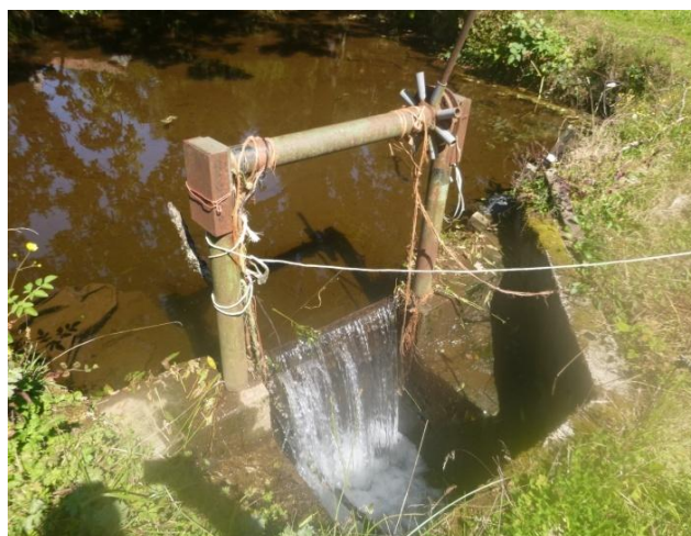
Ouvrage OA5_ESC : vanne levante en fer sur un bras de l'Escalmels au lieu-dit « Escalmels »
