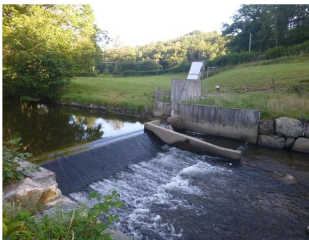
Ouvrage OA25_ROA (ROE40706) : seuil pour la prise d'eau AEP au pont de Lascombes sur le Roannes
