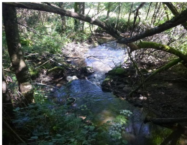
Ouvrage OA6_RES (ROE86965) : enrochements à l'aval du pont de Cros sur la Ressègue
