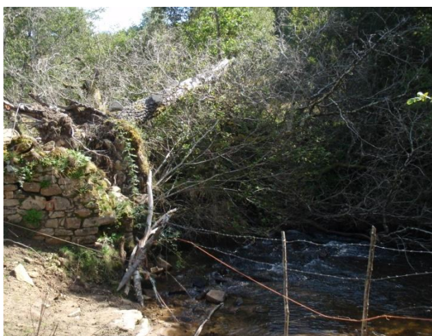
Embâcle géo-localisé dans l'Escalmels entre le pont de Rhodes et celui de la route D25 à l'aval
