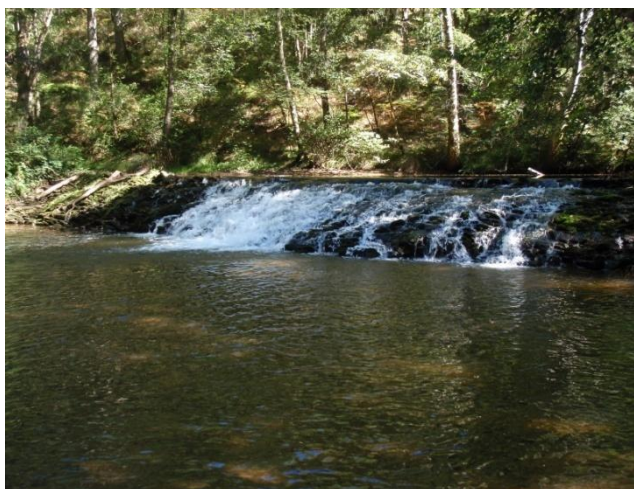
Ouvrage OA27_ROA (ROE39187) : déversoir à l'aval du Roannes permettant l'alimentation d'un bras artificiel
