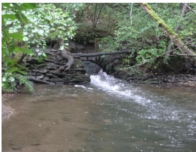
Ouvrage OA5_ROA : déversoir avec une échancrure à l'aval du lieu-dit « Bex » dans le Roannes
