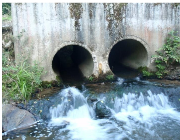
Ouvrage OA6_MOR : buses longitudinales à l'aval du Mourcairol juste avant la confluence avec le Roannes
