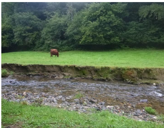
Erosion de berge marquée dans le Roannes à l'amont de Roannes-Sainte-Mary
